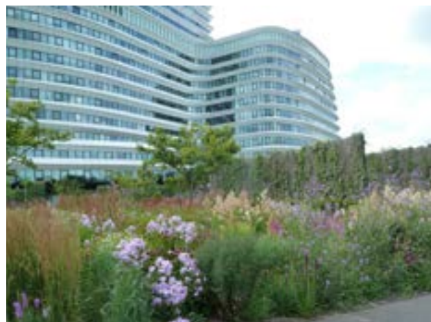
Duurzame kantoren Rijksgebouwendienst, Groningen.
