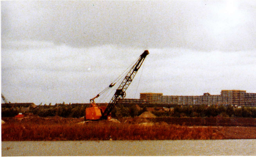
1 ◀ Een begin: zware machines bewerken maandenlang de grond
